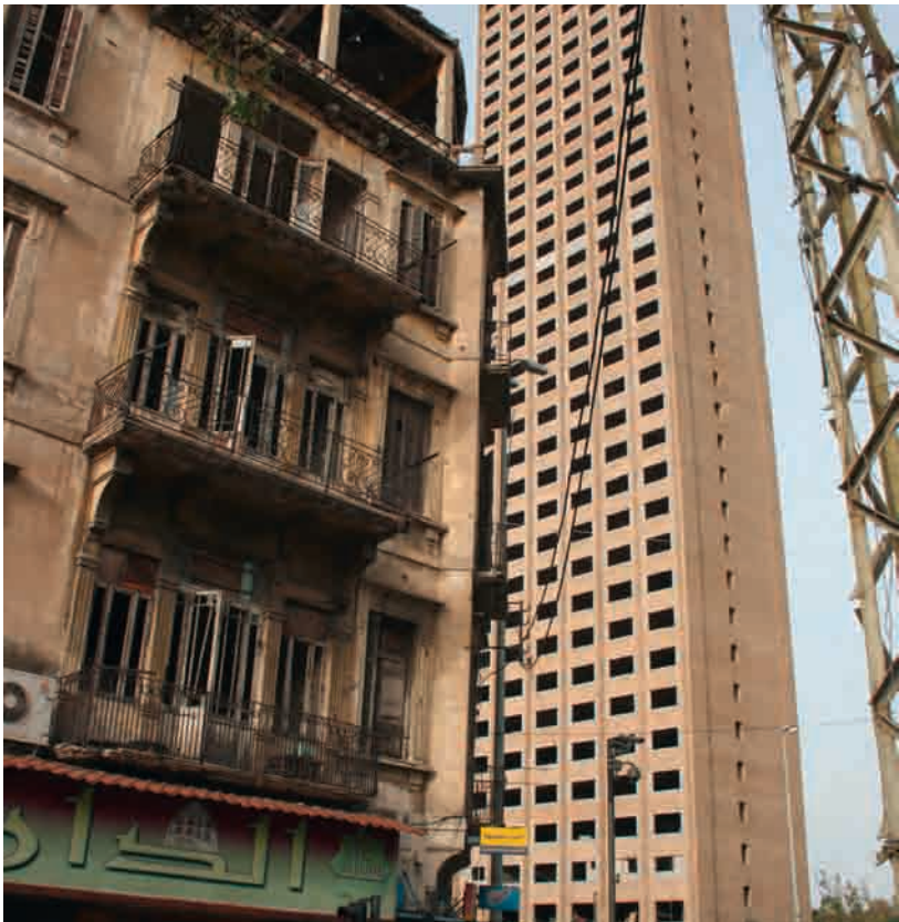
Maison marquée par la guerre et ruine de la tour Murr, jamais terminée, qui servait de poste de tir
